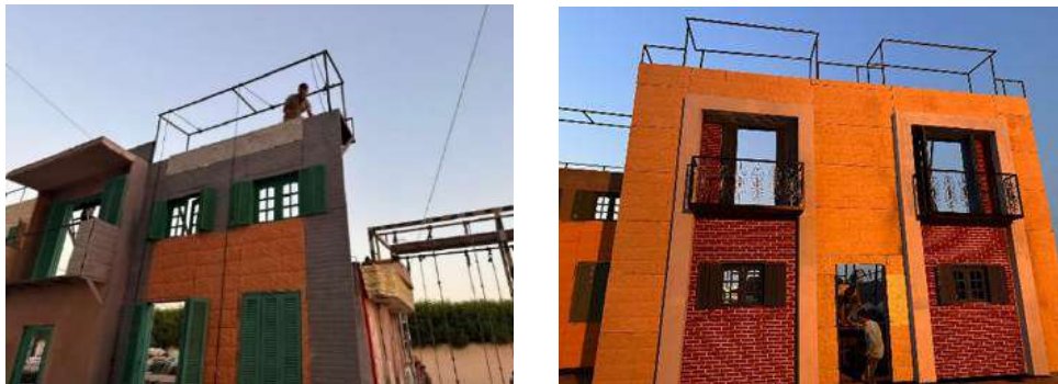
ش 43 تثبت منطقة ، الانزالات علم ، السطح و تركيب الحديد المشغول الخاص ، اساسا الشرفات- تصوير الباحثة - أكاديمية
