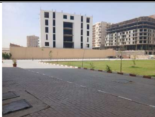
صورة رقم (12) لقطة بعيدة للمسطح الجداري لتوضح اتساع الرؤية حوله
