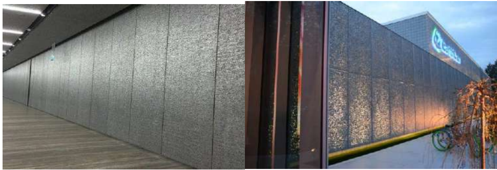
شكل (9) توظيف الرغوة المعدنية داخليا وخارجيا
