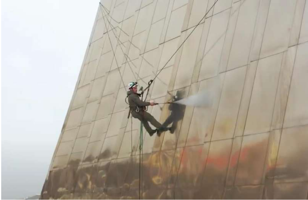
صورة رقم (١٣) توضح احدي العمال وهو يقوم بعمليات التنظيف للنصب التذكاري لغزاة الفضاء باستخدام مضخة المياه ذات الضغط العالي
