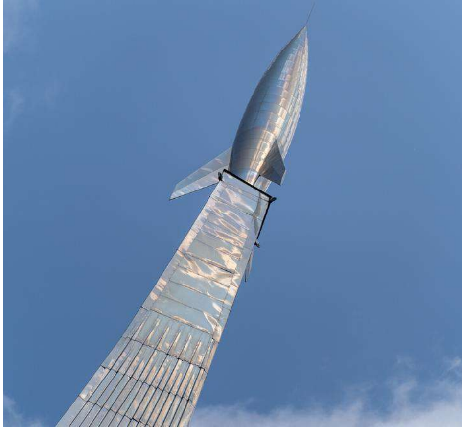
صورة رقم (٥) توضح طريقة تركيب ألواح مصقولة من سبائك التيتانيوم على جسم النصب التذكاري لغزاة الفضاء وهي تعكس السماء بشكل جميل - ١٩٦٤م
