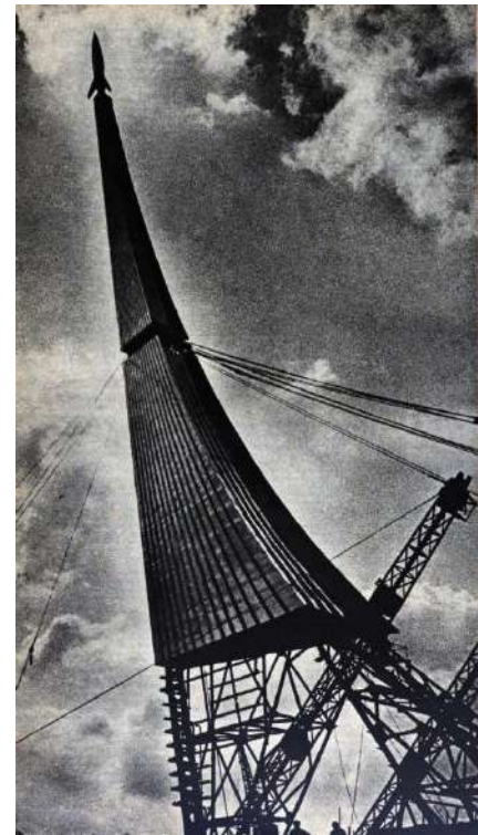
صورة رقم (٧) توضح تجميع الهيكل الشبكي الفولاذي الذي يزن ٢٥٠ طنًا يدويًا على الأرض وُرفِع بواسطة رافعات خاصة بجوار العمل
