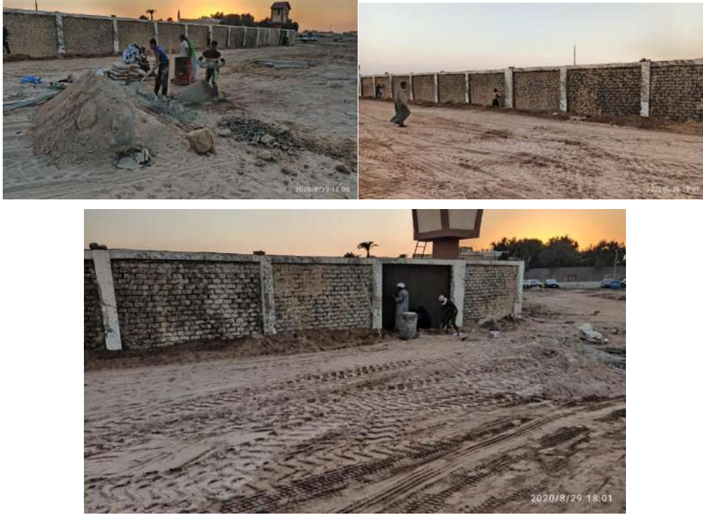
شكل (2) يوضح شكل السور اثناء عملية التجهيز الأولي
