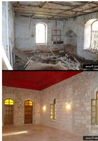
القاعة الرئيسية في مبنى الشهابي قبل وبعد الترميم شكل 4
