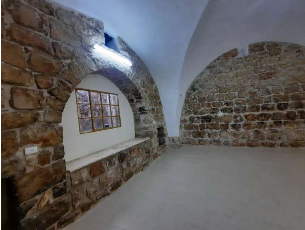
احدى الغرف داخل مبنى الننتشة شكل 21
