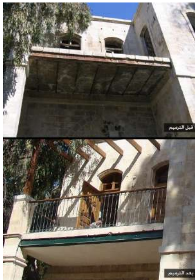
واجهة مدخل مبنى الشهابي قبل وبعد الترميم شكل 5
