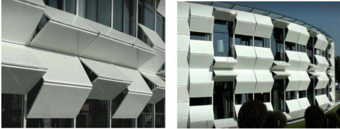
صورة رقم (١) توضح معرض كيفر التفتى بالنمسا، حيث تحتوي واجهة المبنى على هياكل من لوحات معدنية متحركة لتتكيف مع التغيرات المحيطة لتلبية راحة المستخدم في الفراغات الداخلية للمبنى
