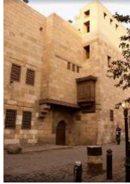
شكل (١٠) الواجهة القبلية لمنزل زينب خاتون وبه المدخل.
