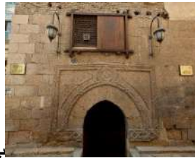
شكل (١٢) أ، ب الواجهة الشمالية الشرقية لبيت الست وسيلة تضم المدخل الرئيسي للمنزل.
