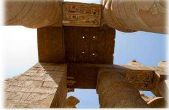
شكل رقم (٢) يوضح فتحات الأسقف - معبد الكرنك
