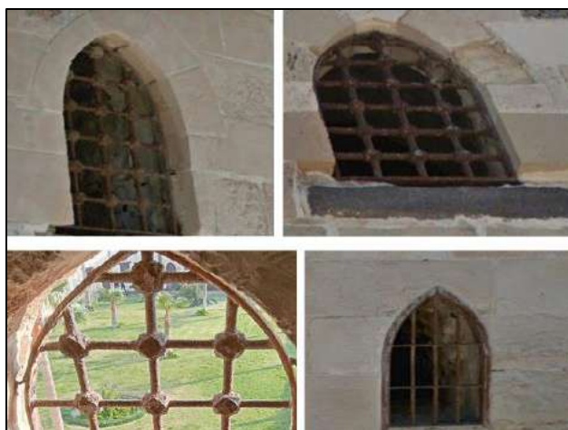
شكل رقم (٥) يوضح تواجد مركبات التآكل على الشبائيك الحديدية
