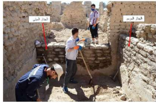
صورة رقم ١١ الجدار المرمم و الجدار المبني عن د. عبد الصمد
