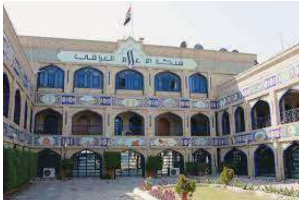
صورة (٤) مبنى شبكة الإعلام العراقي
