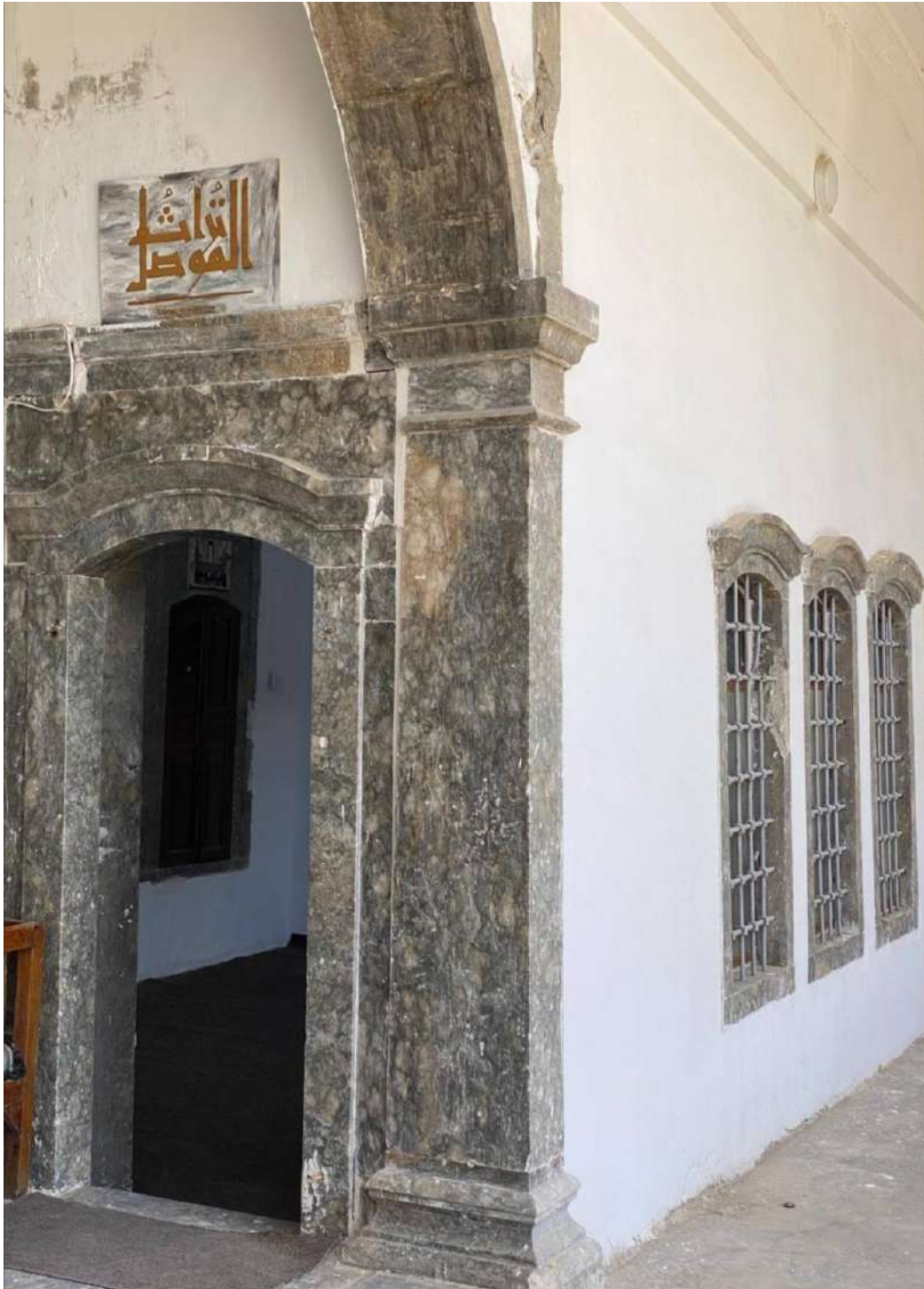
لوحة (7) بيت الطوالب/ عمود مندمج ركني عند مدخل احد الغرف تصوير الباحثة
