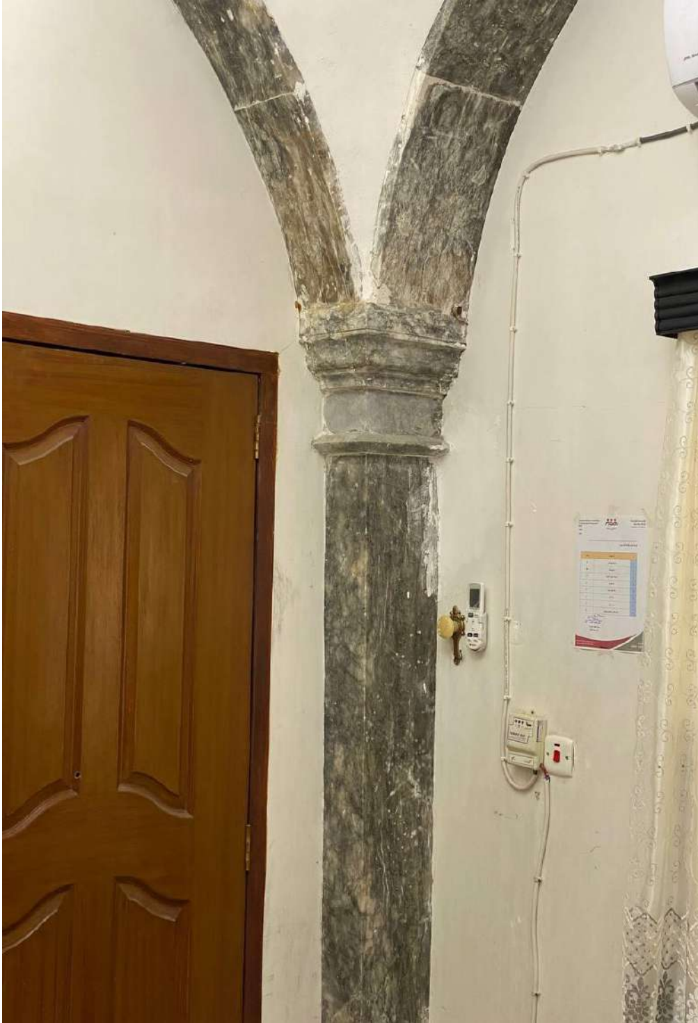
لوحة (8) بيت الطوالب/اعمدة ركنيه ذات عقود ثنائيه في احد غرف البيت تصوير الباحثة
