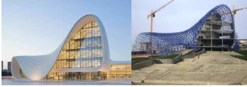
شكل (20) آلية التقسيم للأسطح من الآليات البارامترية القوية التي ساعدت على سهولة تنفيذ الخطوط المنحنية بشكل دقيق جدا في مبنى حيدر حليف الثقافي من أعمال المعمارية زها حديد
