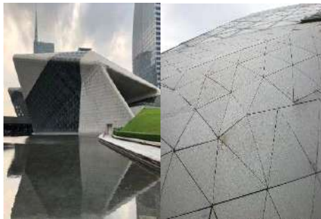
شكل (19) تقسيم السطح الخارجي لدار أوبرا فوانغتشو
