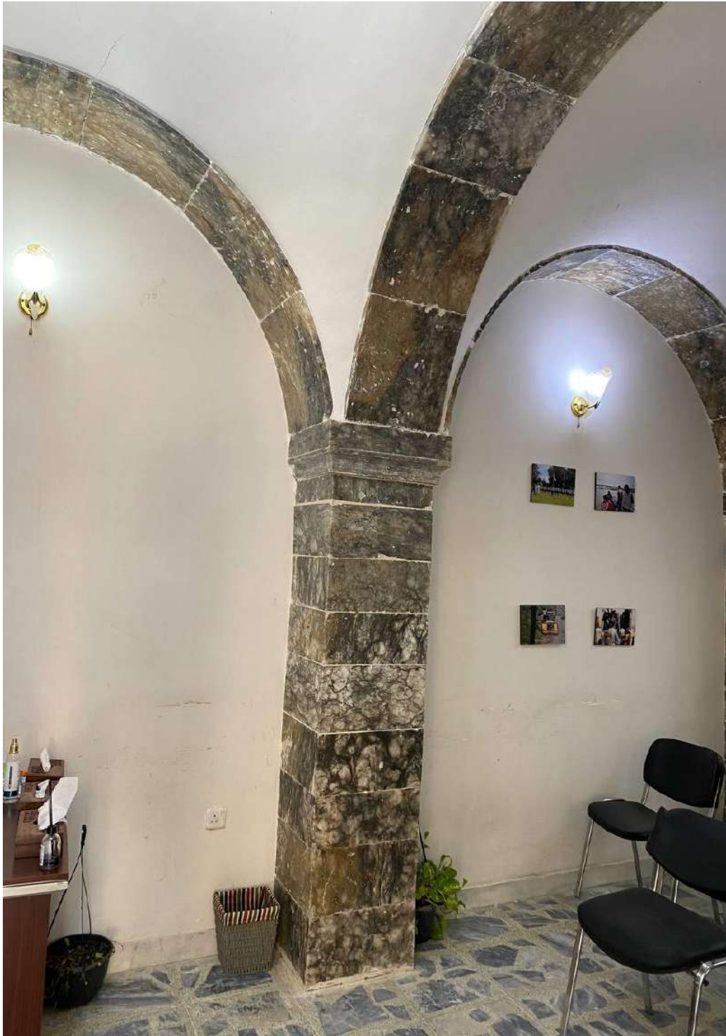
لوحة (9) بيت الطوالب / اعمدة ركنيه ذات عقود ثلاثية في احد الغرف تصوير الباحثة
