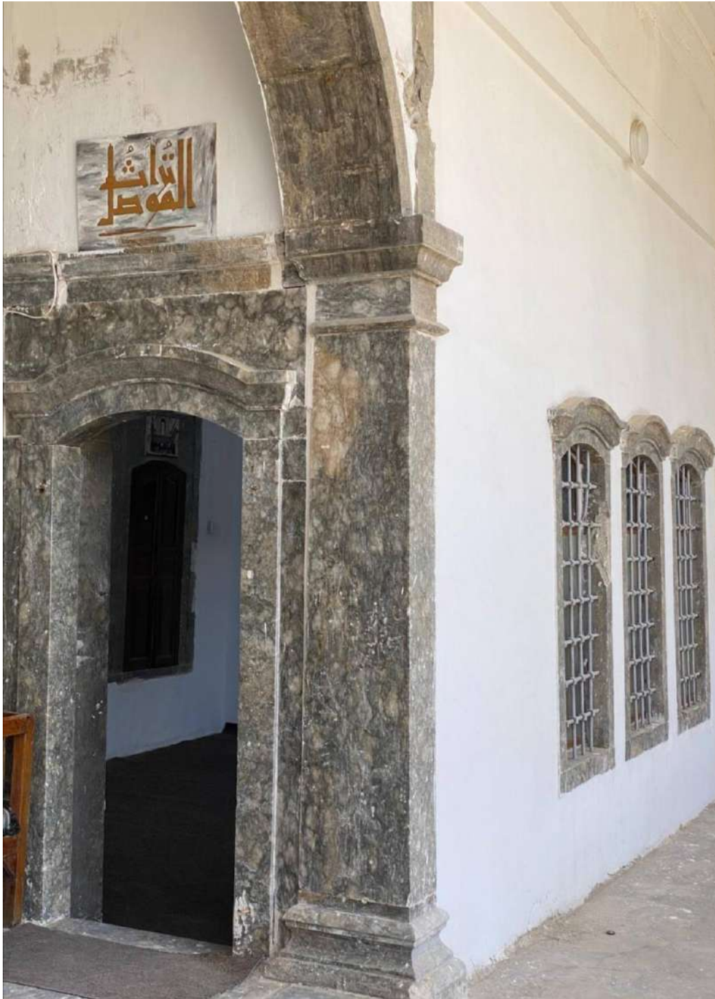
لوحة (7) بيت الطوالب/ عمود مندمج ركني عند مدخل احد الغرف تصوير الباحثة
