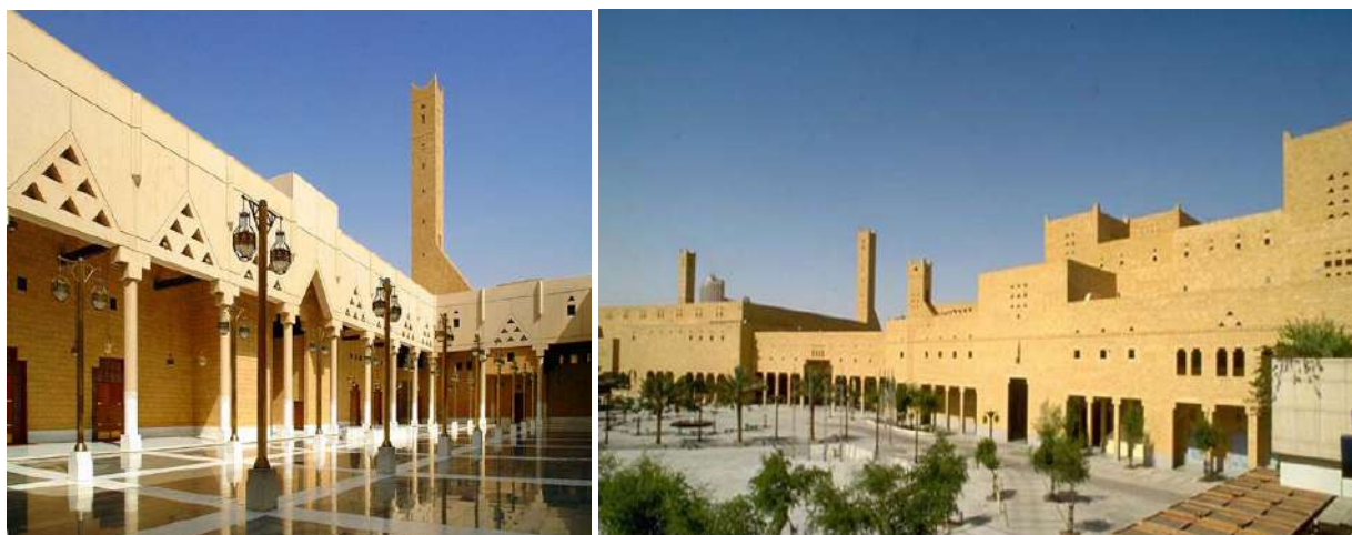
صورة رقم ( 19 ) توضح مشروع منطقة قصر الحكم في الرياض، والذي إستخدم فيه الحجر الجيري لتغطية البناء من الداخل والخارج للمعماري راسم بدران Prof.Dr. Ahmed Atta Prof.Dr. hussien elnabwy · Researcher.Walid Musa Muhammad Metwally Studying environmental architecture trends to development environmental Building · Vol4 · No24 · Dec2024
