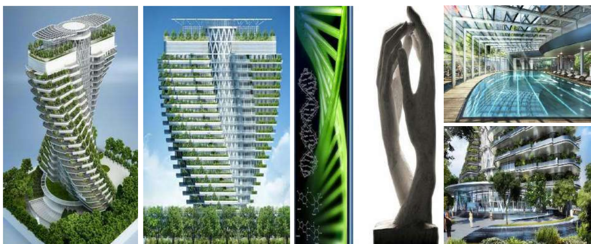
صورة ( 35 ) توضح مبنى المجمع السكني Agora Garden مستوحى من شكل اليدين والبنية الحلزونية من الحمض النووي، ويتم تجميع مياه الأمطار وإعادة إستخدامها مرة أخرى لرى الحدائق للعمل على توفير المياه، كما أيضاً يتم تحويل النفايات العضوية والعمل على إعادة تدويرها كسماد خاص بالحدائق
