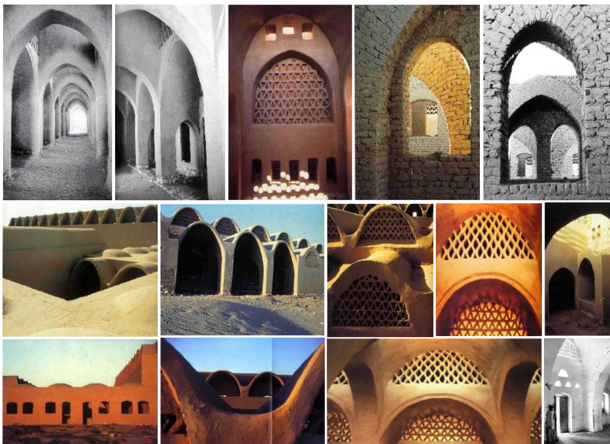
صورة رقم ( 13 ) توضح صور مدينة باريس الجديدة في واحة الخارجة توضح طرق الإنشاء وفتحات التهوية للمعماري حسن فتحي 1967 (ب) منزل الدكتور فؤاد رياض في شبرامنت 1973 وقد استخدم فتحي في إنشائه الحجر بدل من الطوب الطيني .
