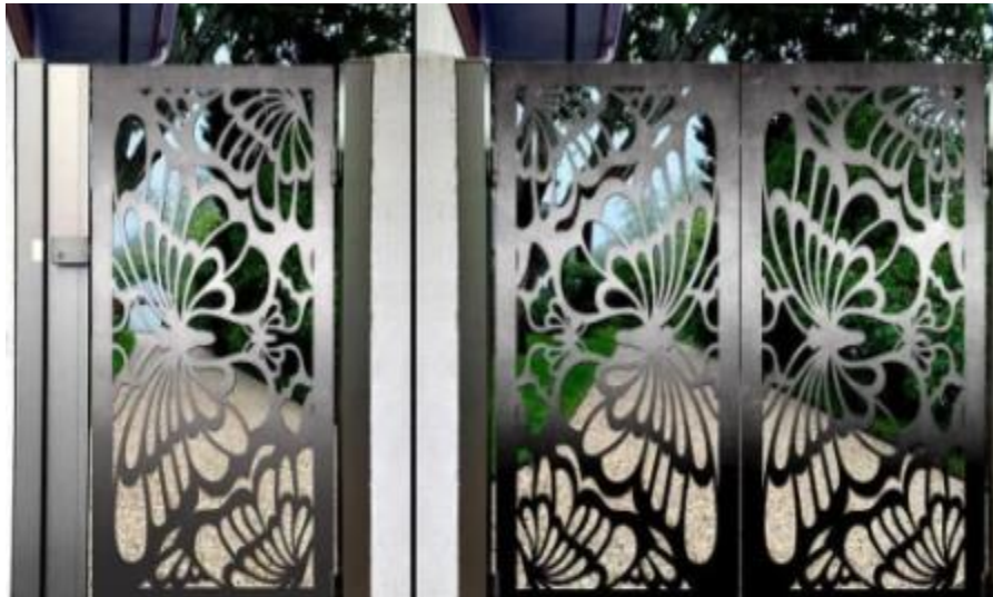
شكل رقم (٧) استخدام تقنية القطع بالليزر في الحديد المشغول
