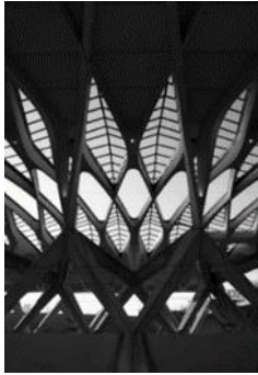
شكل رقم (١٠) محطة ليون من الداخل. المصدر: https://divisare.com/authors/8968-santiago-calatrava/projects/built
