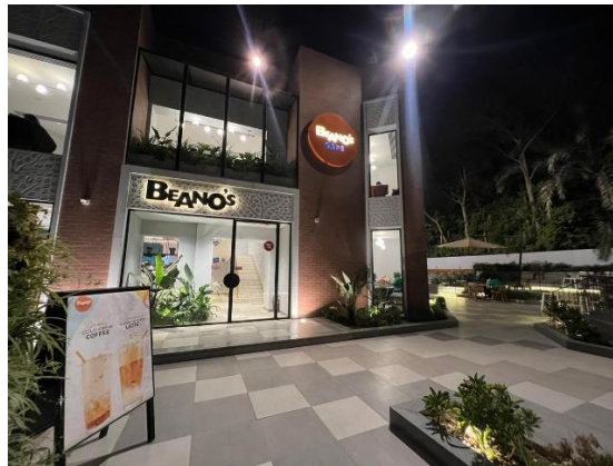
شكل (13) يوضح واجهة المبنى الخارجية - بعد التعديل
