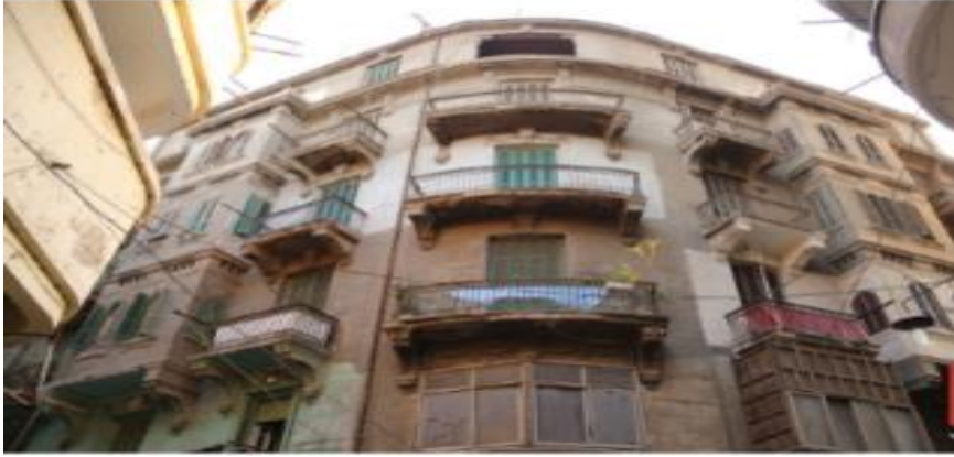
صورة رقم ( 11 ) توضح مبني تراثي تم هدمه بمنطقة مثلث ماسبيرو، عقار رقم 18 شارع ابن اليازري.
