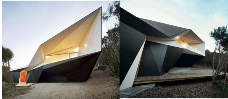
صورة (٣١) منزل العطلات المعروف باسم كلين بوتل "Klein Bottle house" من تصميم McBride Charles Ryan بأستراليا عام ٢٠٠٨ متأثراً بفن طي الورق الأوريغامي , وهو مصنوع من ألواح الاسمنت المعز بالألياف Fibre Reinforced Cement. (١٣)
