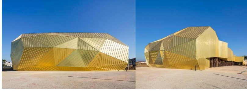
صورة (٢٩) مبنى قاعة رياضية لا فونتائين Gymnasium La Fontaine, بفرنسا المصنوع من خليط معدني من النحاس والألومنيوم ذهبي اللون, من تصميم (TECNOVA Architecture). (١٠)
