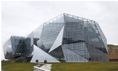
صورة (٢٨) واجهة مبنى E8-Building المنفذة من المعدن والزجاج، حيث يظهر مبدأ البناء والتراكم من خلال تصميم المبنى وهو من اهم مبادئ عمارة الطي.
