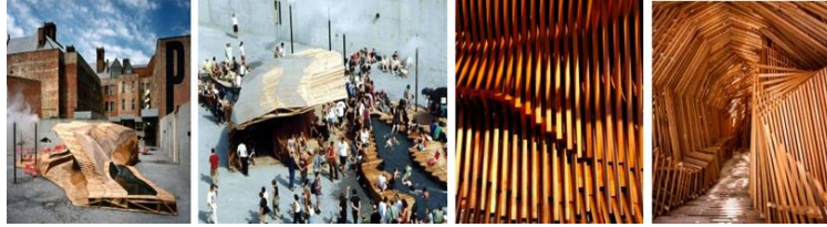
صورة (٢) تقنية التقسيم واستخدامها في أحد المشاريع الطلابية , وهو عبارة عن جناح تم تصميمه وتجميعه في نفس الموقع.
