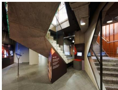
صورة (٢٢) توضح التشكيل باستخدام الخامات المختلفة ، الزجاج في الحوائط الفاصلة بين الفراغات ، الحجر في الأرضيات ، والخرسانة المسلحة في تكسيه السلم و ألواح النحاس في الحوائط.
