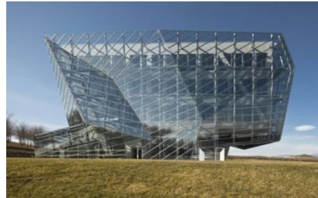
صورة (٢٨) واجهة مبنى E8-Building المنفذة من المعدن والزجاج، حيث يظهر مبدأ البناء والتراكم من خلال تصميم المبنى وهو من اهم مبادئ عمارة الطي.
