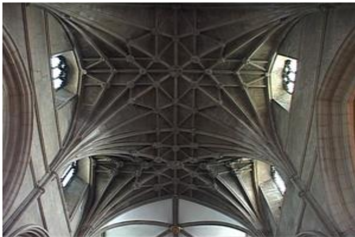
شكل ( ٦ ) يوضح رؤية القوس المدبب بشكل ثلاثي الابعاد (القبو المضلع)
