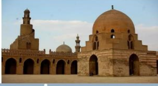
شكل ( ٩ ) يوضح العقد المدبب ذو المركزين و العقد الخموس للمسجد
