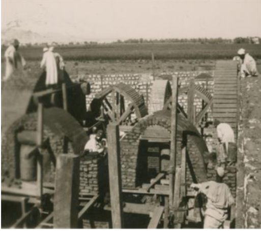
صورة رقم (٧) توضح استخدام الطوب اللبن والحجر في بناء مركز رمسيس وصيا واصف
