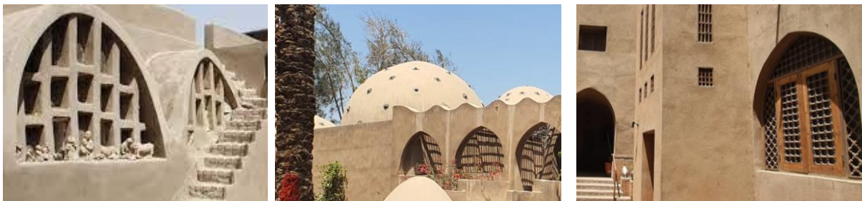
صورة رقم (٣) توضح استخدام المشربيات والأسقف والجدران الخارجية المفتوحة في مركز رمسيس ووصاف
