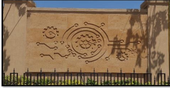
صورة رقم (٢): توضح استخدام تقنية الحفر الآلي على الحجر الهاشمي. مصدر الصورة: (تصوير الباحثون)
