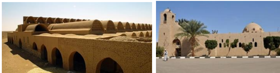
شكل 4 مباني قريتي القرنة وباريس لحسن فتحي واستخدامه للمواد المحلية والقباب والفتحات النصف دائرية (حسانين, 2018).
