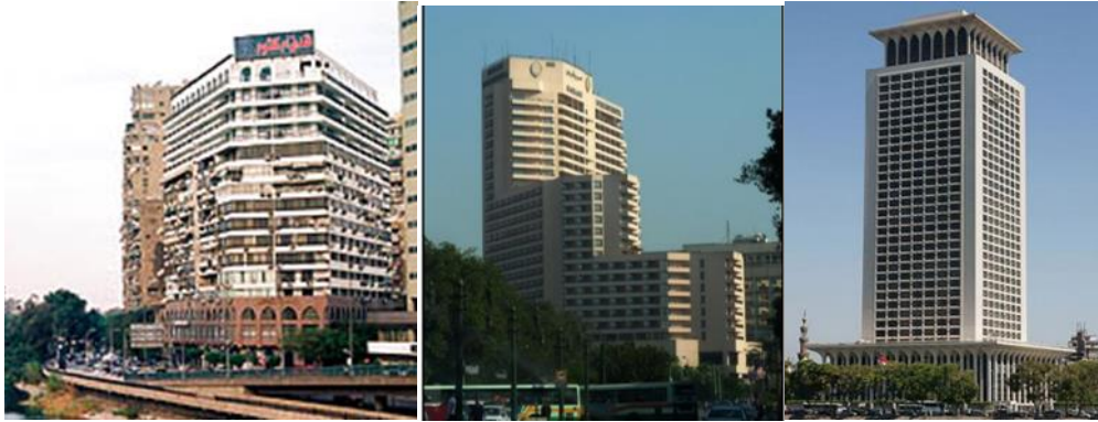
شكل 3 برج أم كلثوم علي النيل, مبنى سميراميس انتركونتينتال لبنيامين طومسون, وزارة الخارجية لمحمد رمزي (عمارة, 2011).
