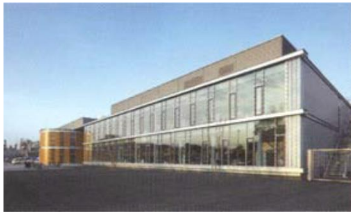
الشكل 8: المظهر الخارجي لمركز العلوم و الأعمال Bio & Nanotronics. [19]
