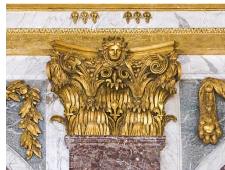
FIG.21 : DETAIL D'UNE COLONNE DE LA GALERIE DES GLACES, CHAPITEAU D'ORDRE FRANÇAIS PAR LE BRUN ET COMBINAISON ENTRE MARBRE DE CARRARE, CAMPAN ET RANCE AVEC BRONZE DORE.
