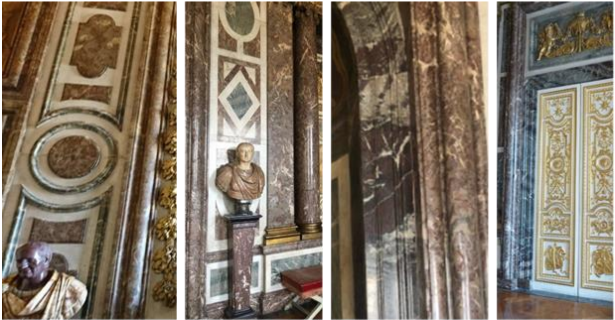
Fig.17 : (A) Des modénatures des diverses épaisseurs et des moulures profondes au salon de Diane (B) Lambris arasés tables de marbres au salon de Vénus (C) et (D) Encadrements de moulures profondes pour la niche au centre de la composition ainsi que les portes et les tableaux.
