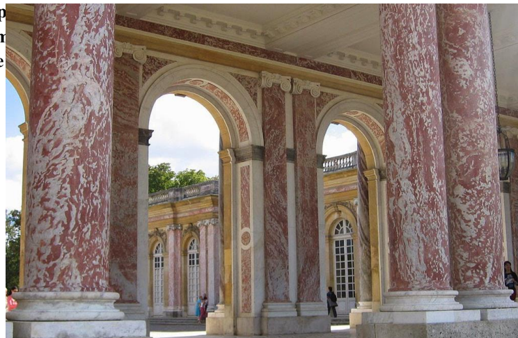
FIG.٣ : GRAND TRIANON : LES 183 PILASTRES ET LES 14 COLONNES PORTEUSES SONT REVETUS DE MARBRE ORIGINAL DU SUD DE LA FRANCE, INCARNAT DE CAUNES, LE POURPRE EST SYMBOLE DE LA PUISSANCE DU ROYAUME.
