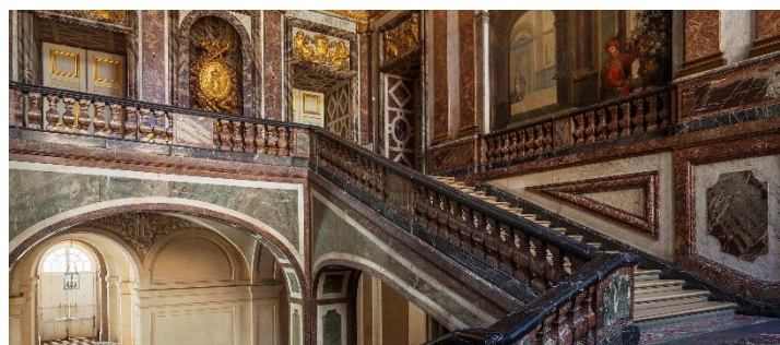
FIG.7 : L'ESCALIER DE LA REINE – VERSAILLES : CAMPAN VERT ET GRAND MELANGE INCRUSTES HARMONIEUSEMENT COMME DES PIÈCES DE MARQUETERIE AVEC FOND DE CARRARE, LA NICHE EST EN GRAND MELANGE, LE RANCE ENCADRE LES PANNEAUX DE CAMPAN, REVET LES BALUSTRADES ET LES PILASTRES AU NIVEAU SUPERIEUR.
