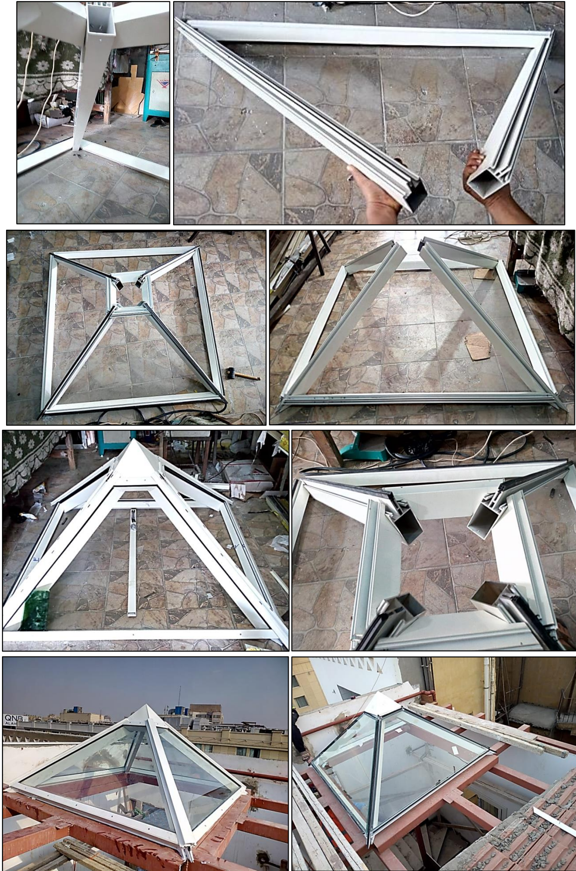
شكل (٧) يوضح الوحدة التكرارية للسقف المعدني بعد تنفيذها باستخدام التصنيع الرقمي
