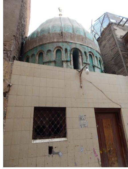
لوحة (١٧) الواجهة الجنوبية الشرقية لضريح سيدي محمد الواعظ ويظهر بها التعديلات الحديثة على القبة، تصوير الباحثان
