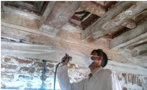
(صورة ٤٥): مد طبقة الورنيش النهائية بواسطة مسدس الهواء، عن (مشروع الجامع الكبير)
