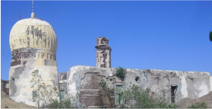
(لوحة ٥) الواجهة الجنوبية الشرقية للمسجد وواجهة القبلة
