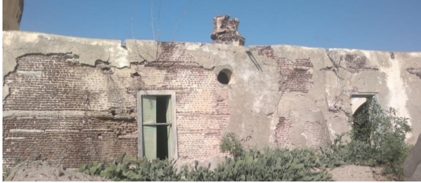
(لوحة ٤) الواجهة الجنوبية الشرقية للمسجد
