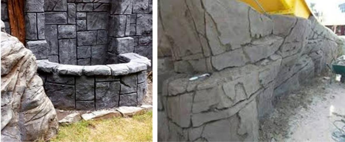
شكل (١٧) تكسية "جدار صخري" بداخل حوض سباحة بتقنية الصخور الصناعية.
