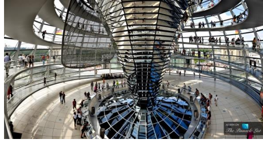
صورة (١، ٢): "تعتبر القبة مكونا رئيسيا في استراتيجيات الإضاءة وتوفير الطاقة، حيث تنتقل الإضاءة الشمسية المنعكسة عن المرايا التي تكسو المخروط المقلوب داخل قاعة البرلمان أسفل القبة الزجاجية." (١٩)
