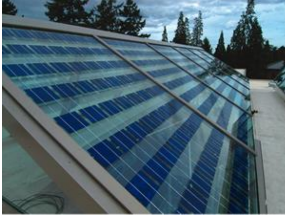
شكل (١٣) صورة (٩): "وحدة الـ"SPVS": لقطة منظورية تفصيلية لشكل العوارض وطريقة تثبيت طبقتي الزجاج بالعوارض." (١٤، ٢٢)
