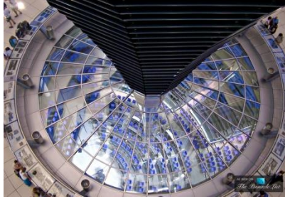
صورة (١، ٢): "تعتبر القبة مكونا رئيسيا في استراتيجيات الإضاءة وتوفير الطاقة، حيث تنتقل الإضاءة الشمسية المنعكسة عن المرايا التي تكسو المخروط المقلوب داخل قاعة البرلمان أسفل القبة الزجاجية." (١٩)
