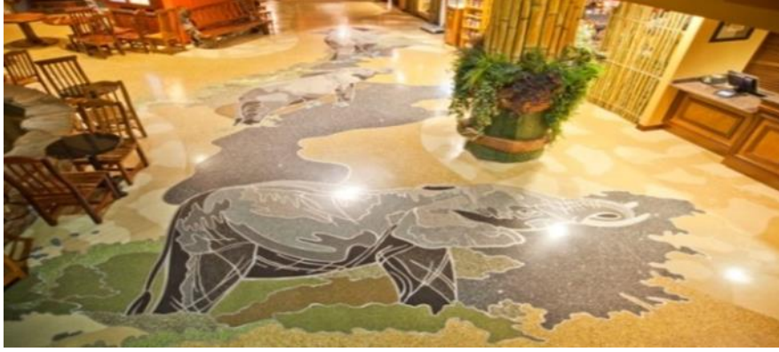
الشكل رقم ( ١٧ ) يوضح إستخدام طباعة النانو على الرخام
