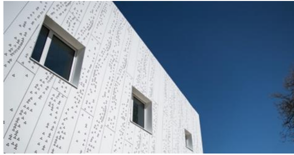
الشكل رقم ( ١٣ ) يوضح استخدام ألومنيوم النانو في الواجهات الخارجية
