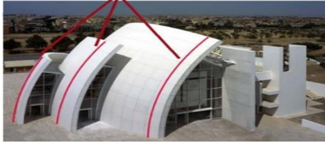
الشكل رقم ( ١٤ ) يوضح أشرعة كنيسة اليوبيل في روما باستخدام خرسانة بتقنية النانو
