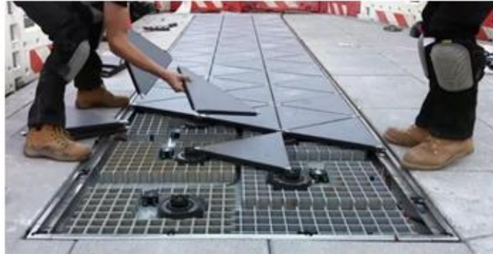
صوره (٦) الارضيات التفاعلية المكونة من بلاطات يتم تثبيت مجسات أسفلها للتفاعل مع حركة الإنسان.
