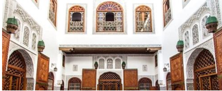
الصورة (٦) توضح الدربوز في الطابق الثاني وهو عبارة عن شبك من خشب ونحوه على شكل قوائم تقام حاجزا في مقدمة الغرف بالطابق الثاني من الدار
