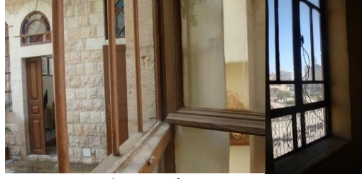
صورة (١٧) الى اليمين سماكة الجدران في الطابق العلوي والى اليسار سماكة الجدران في الطابق الأرضي. (تصوير الباحث)
