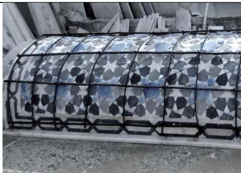
صورة(30): بعد اكمال تنسيق قطع الفسيفساء، وتركيب أسياخ الحديد تمهيداً لصب المونة عليها.
