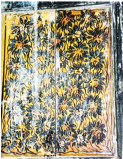
لوحة ٢ توضح زهرة القرنفل على الاسطح الداخلية للجدران، مسجد قرية بيلن ارتيتش ١٣٠١هـ/١٨٨٤م
