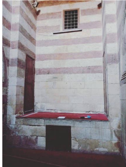
الصورة (١٤) : الدركاه من الداخل والمسطبة بالحائط المقابل للمدخل المصدر : تصوير الباحثة
