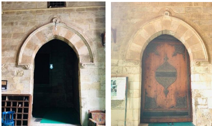
الصورة (٥) و(٦): توضح العقود المدببة ذات المركزين بباب الدهليز والمدفن المصدر: تصوير الباحثة
