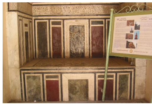
الصورة (٩) توضح حوائط المسطبة المكسوة بالرخام الملون المصدر : تصوير الباحثة
