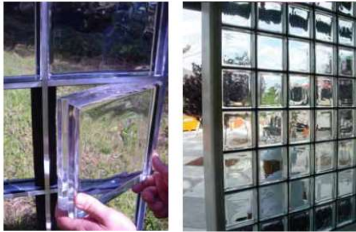
شكل (15) يوضح طريقة تركيب البلاطات داخل قطاعات الالومنيوم
