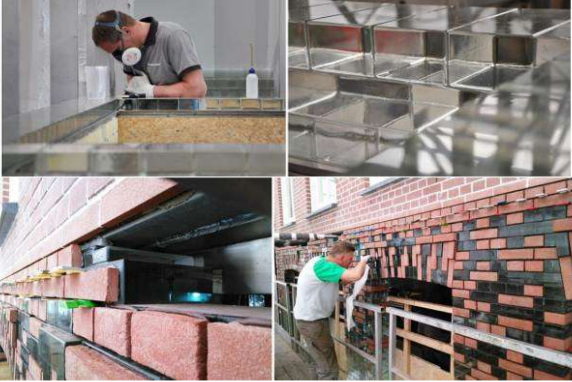
شكل (23) يوضح مراحل التركيب في الواجهة للمبنى
