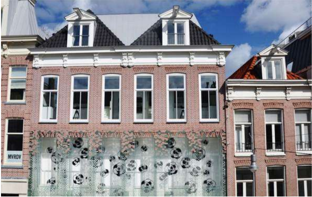
شكل رقم (26) يوضح صورة المبنى بعد التركيب النهائى للجدار المكون من الطوب الزجاجى
