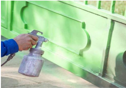
شكل (18) عملية الطلاء بالدهانات العضوية
