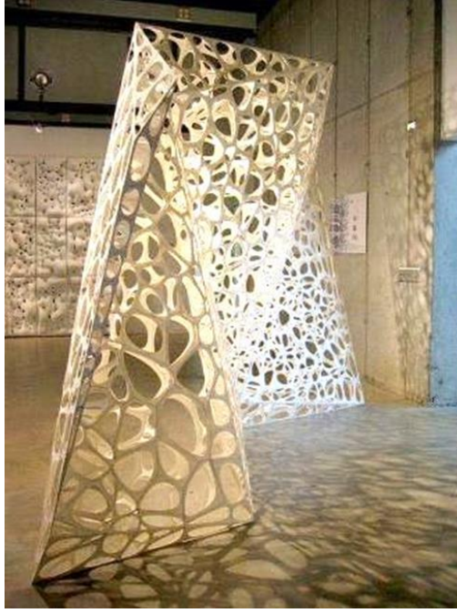
شكل رقم (10) يوضح صورة فاصل ثابت من مادة الجي أرسى GRC منفذة عن طريق الأساليب الخوارزمية والتصميم الباراميتري
