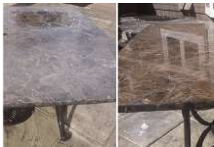
صورة ( 18 ) - توضح تآكل سطح المنضدة الرخامي Etching علي اليسار مقارنة بشكل الخامة الأصلي قبل التآكل علي اليمين .
