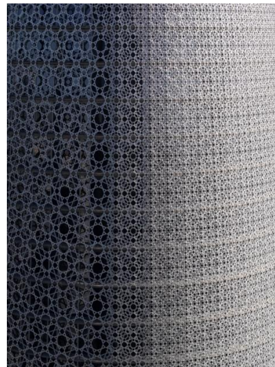
( صورة 27 ) : عمل طبقات مختلفة من المشربية بطول الواجهة بأحجام مختلفة لمنع اشعة الشمس المباشرة وتساعد على خفض درجة الحرارة للجدران الداخلية للمبنى .
