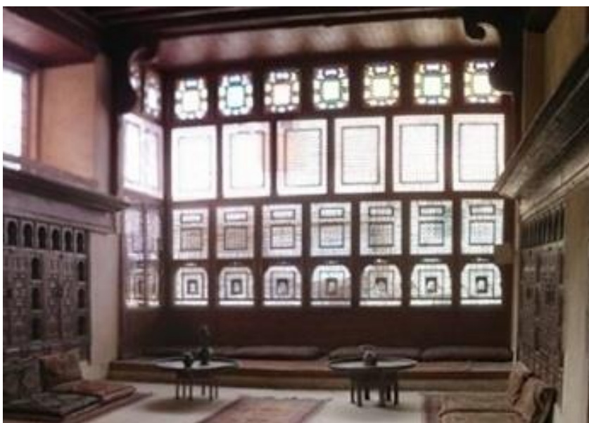
( صورة 8 ) : تقسيم المشربية إلى جزأين : سفلى بخرط صغير وفراغات ضيقة وعلوى بخرط كبير (صهرجي) وفراغات واسعة لمنع اشعة الشمس المباشرة و لضبط الاضاءة داخل المكان .
