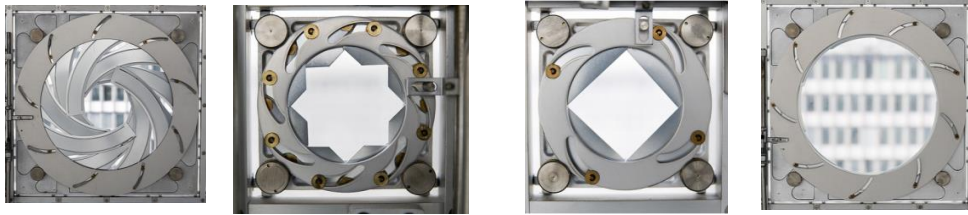
( صورة 24 ) : مراحل إغلاق العدسة وفقا لضوء الشمس الخارجي لضمان مستوى مريح من الاضاءة .
