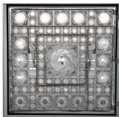
( صورة 23 ) : الشبكة المعدنية وحدة التصميم مستوحاه من الزخرفة الإسلامية ومفهوم المشربية التقليدية وفكرة عدسة الكاميرا التي تفتح وتغلق تلقائيا
