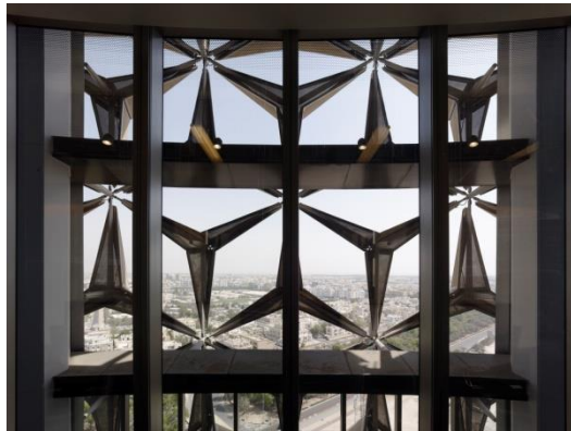
( صورة 34 ) : عندما تغلق المشربية على نفسها عند غياب الأشعة المباشرة للشمس تسمح برؤية الخارج و دخول ضوء النهار
