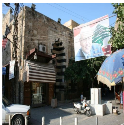
لوحة (3) الواجهة الرئيسية للمدرسة النورية
