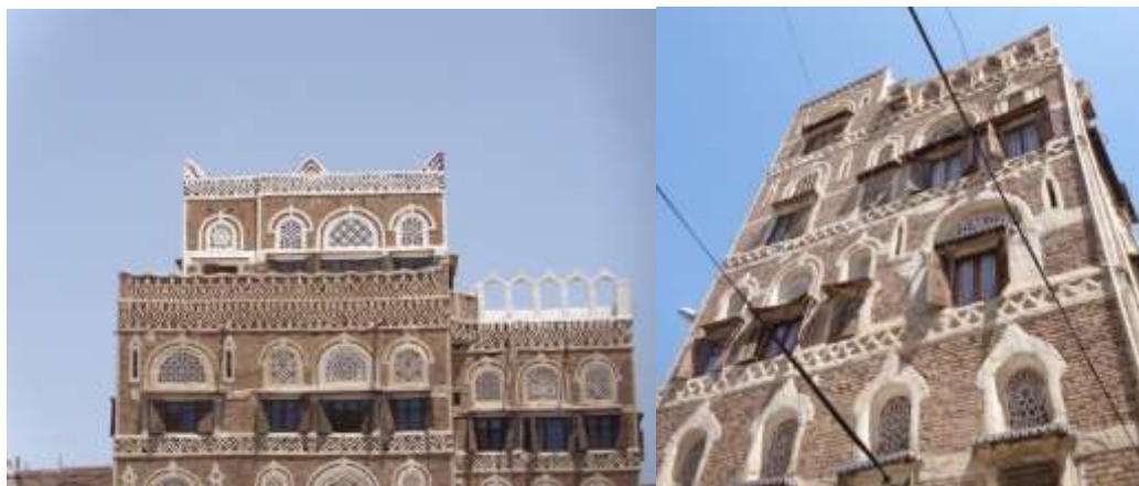
صورة رقم (10) , (11) توضح خطوط عمارة صنعاء والعناصر المعمارية لواجهتها (المصدر: الباحثة)
