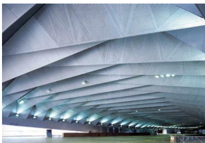
صورة (13) لمشروع تصميم السقف الهيكلي المطوي من الصلب لميناء الرحلات البحرية الدولية بيوكوهاما.
