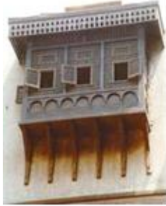
شكل ( 35 ) مشربية تصنع من قطع صغيرة من الخشب توضع على مسافات صغيرة تحجب الضوء.
